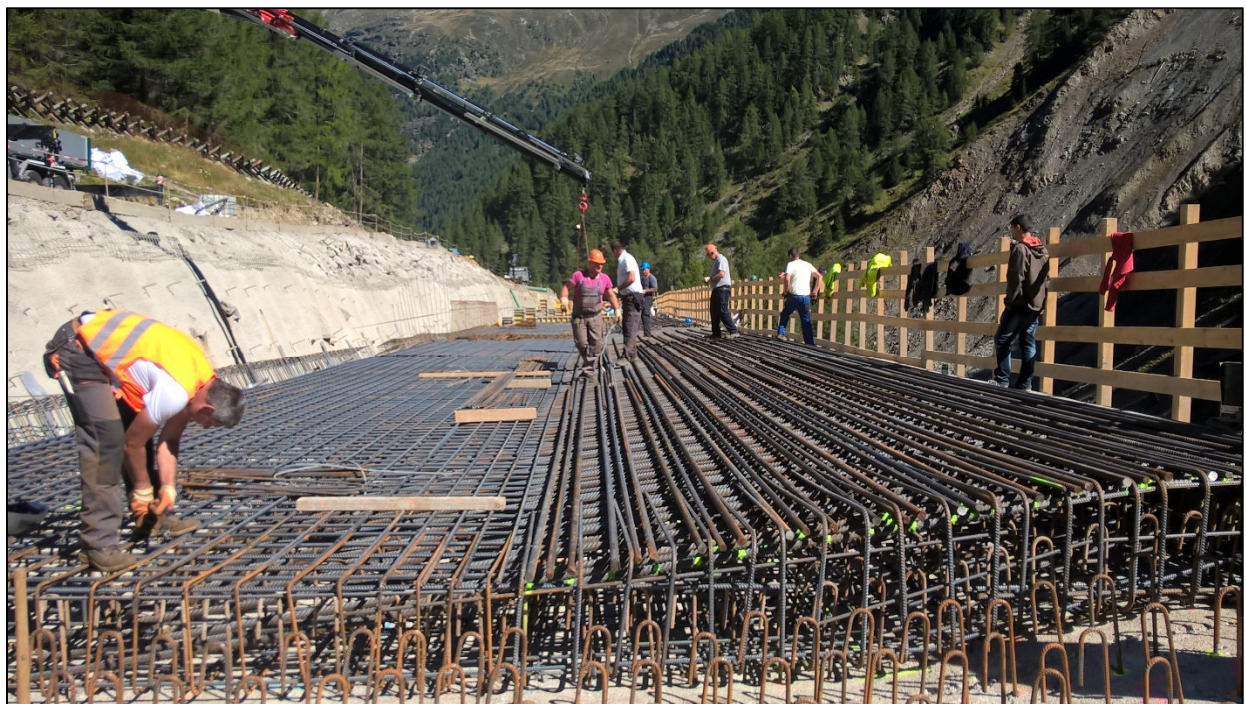
Bild 10: Bewehrung Aufbetonplatte
