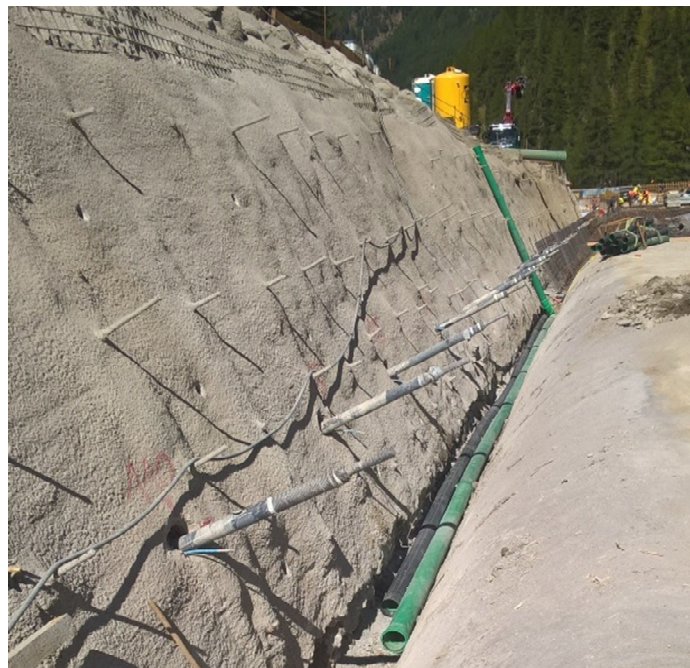
Bild 8: Verpressanker
