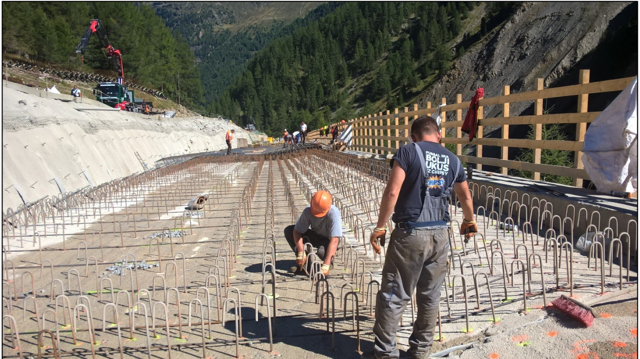
Bild 9: Schubverdübelung
